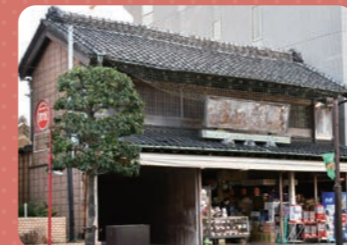
大正7(1918)年築の切妻造瓦葺の建物。市の景観重要建造物
