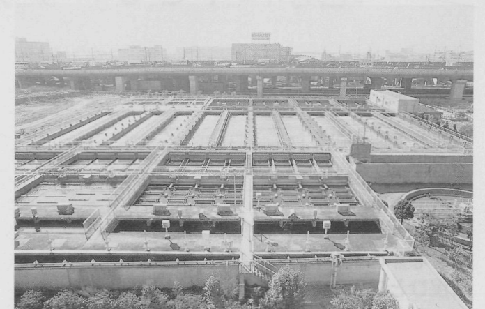
西浦下水処理場。1日あたりの処理能力を、4万8800立方メートルから6万1600立方メートルに高める増設工が始まります
