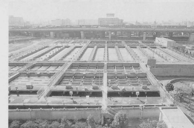
西浦下水処理場。1日あたりの処理能力を、4万8800立方メートルから6万1600立方メートルに高める増設工事が始まります
