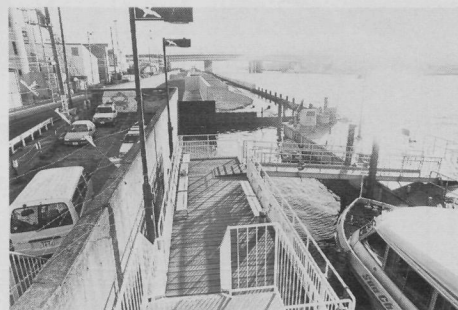
浜町の棧橋付近では展望広場や見晴らし台のある親水緑地の建設工事が進められています
