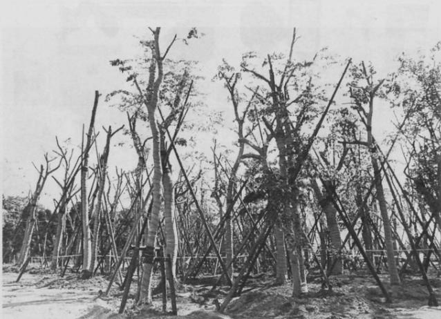
アンデルセン公園の建設現場。自然の樹木を伐採せず、移植して残す方法で工事が進められています
