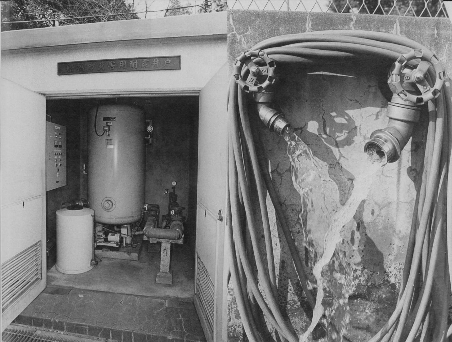
地下100メートルから水をくみ上げる災害用耐震性井戸のポンプ室。滅菌機も取り付けられています
