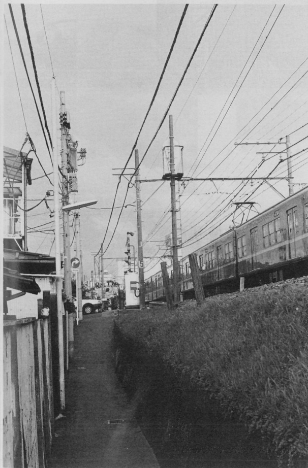
工事が終わると、線路の北側には幅6mの環境側道が誕生する
