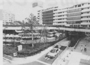
今年4月に完成した、総武線沿線でも最近代的なJR船橋駅北口広場
