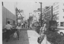
再開発ビルの建設が進む市民文化ホール前
