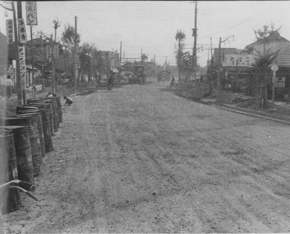
中央公民館前で行われた道路の補修工事(昭和30年10月)。10月1日に行われた第8回国勢調査によると、市の人口は約11万5000人、世帯数は約2万3400世帯であった
