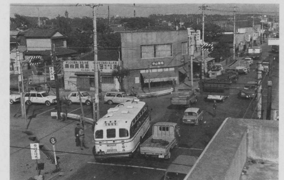
国道14号から国鉄船橋駅南口に向かう交差点。この写真を 撮影した昭和39年5月には、市の人口が20万人を突破した
