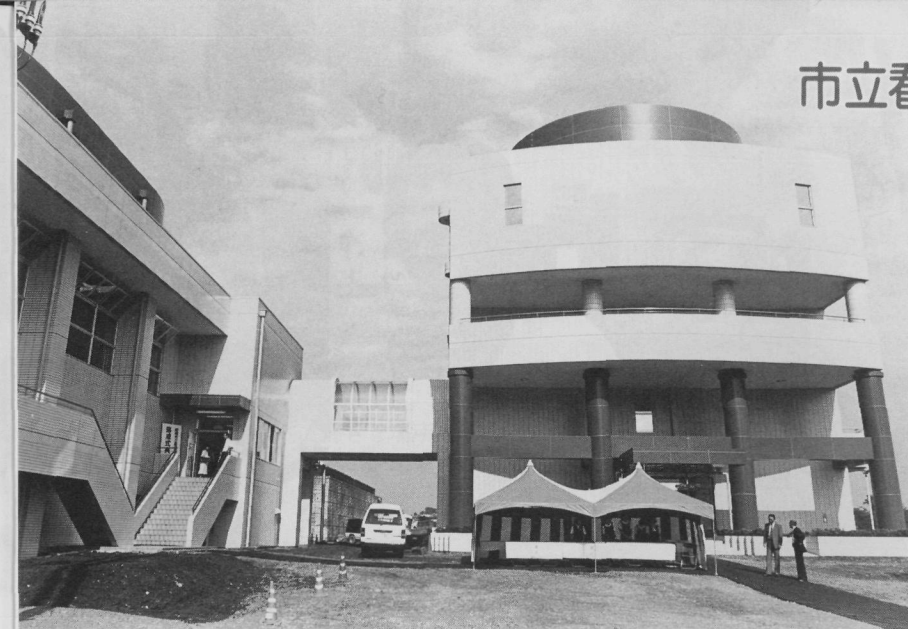
淡いピンクの外壁とぞん新な外観が印象的な市立看護専門学校
