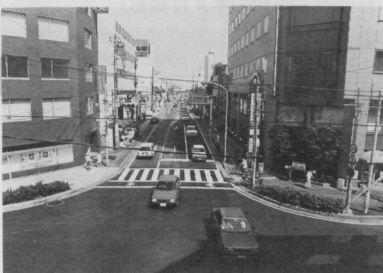
国道14号湊町交差点から千葉方面を望む
