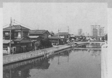
護岸整備が進む海老川 (船橋橋付近)
