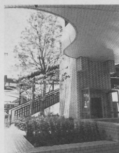
地下駐車場と地上およびデッキを結ぶエレベーター
