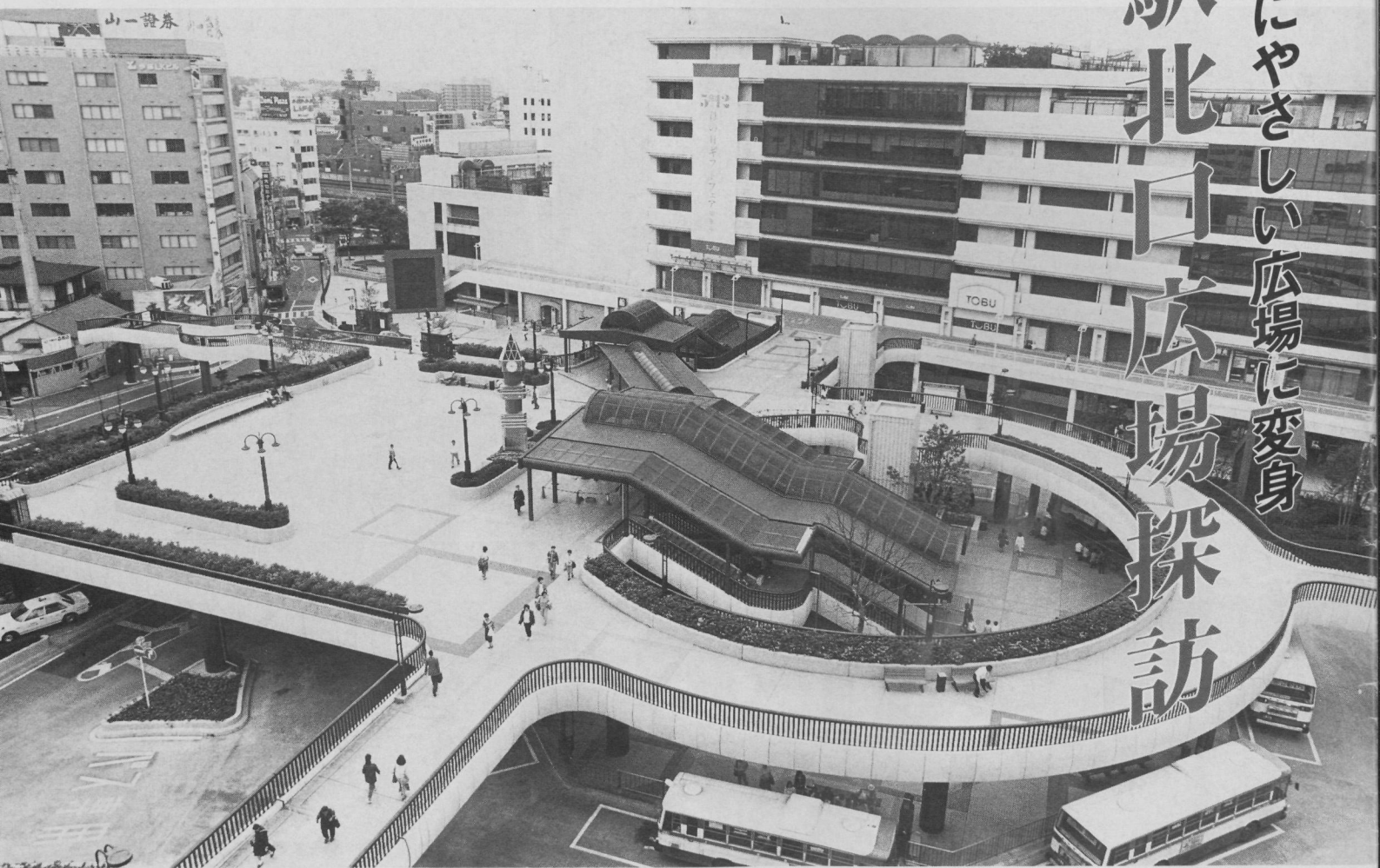
船橋駅北口駅前広場
