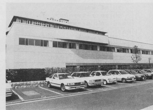
医療センターに隣接して建てられたMRI・リハビリ棟
