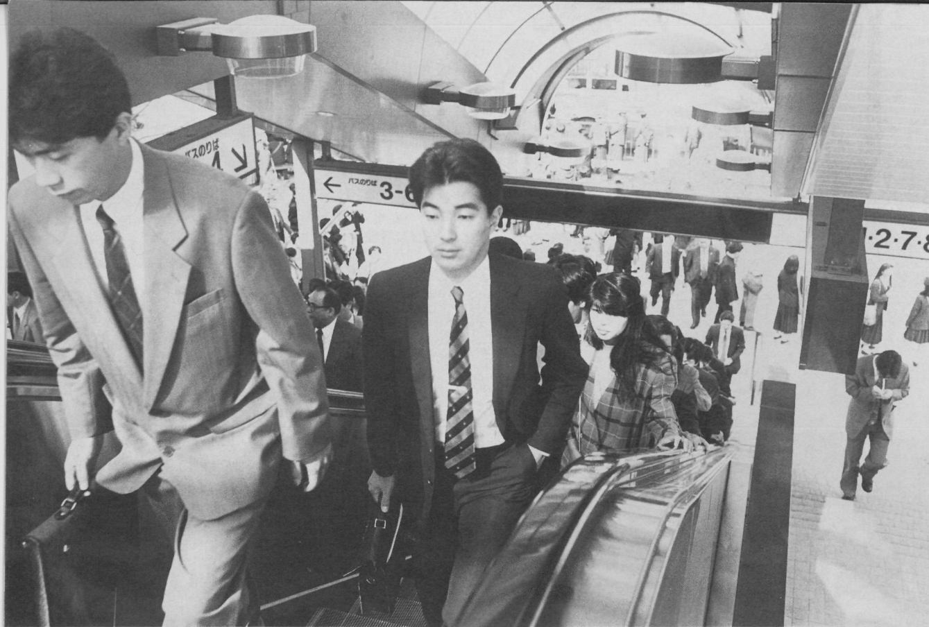
ペデストリアンデッキとバスターミナルを結ぶエスカレーター。人の流れに合わせ、昇り降りが変えられる
