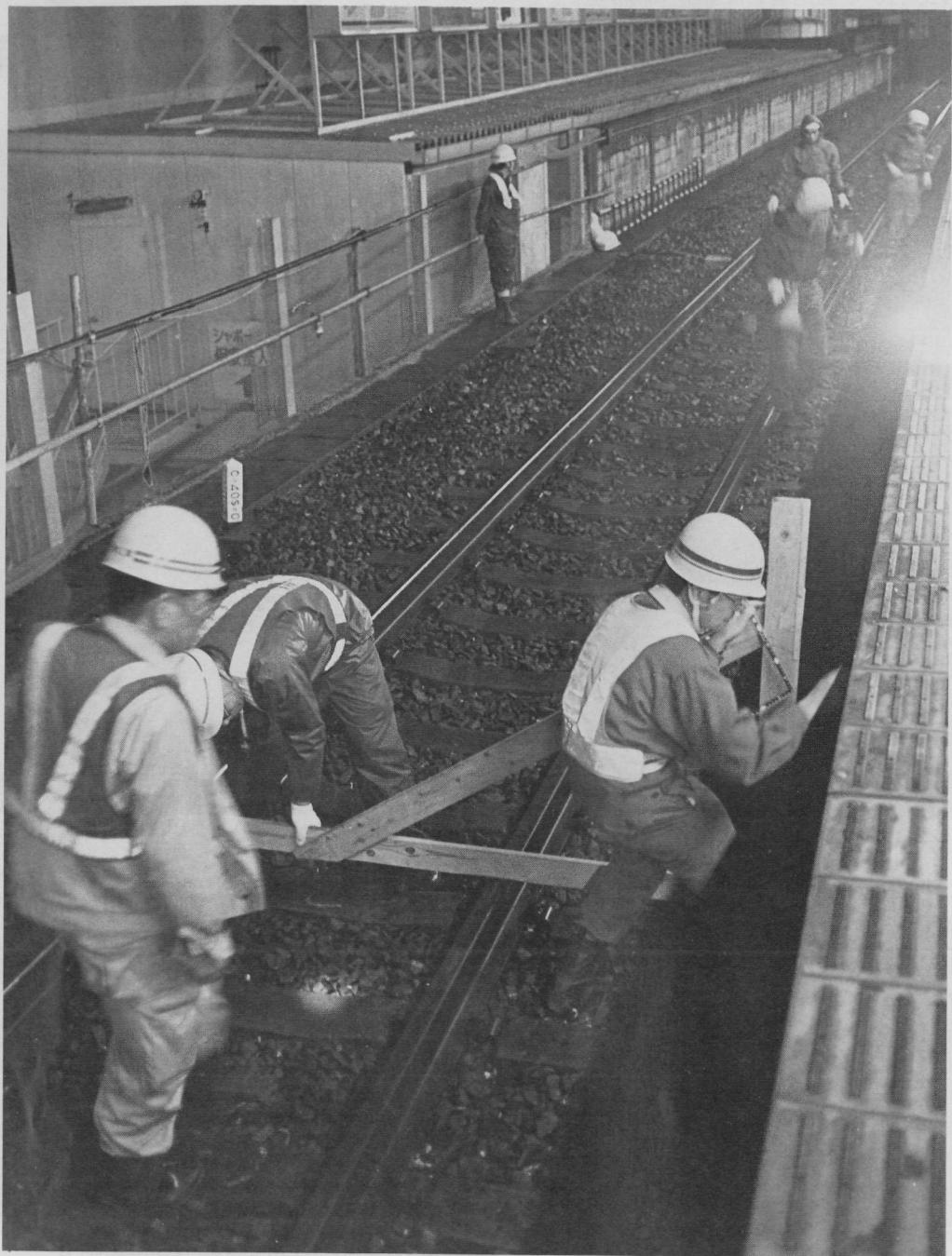
午前1時30分、保線開始 (JR船橋駅)。線路の幅、ホームとの距離などが正確に計られ、調整されていく
