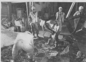
深夜の道路工事 (丸山1丁目)
