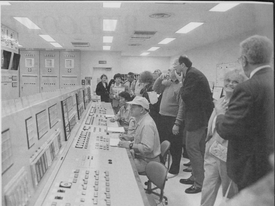
アメリカは広大な国土を持つため、今までハイワード市ではごみを全て埋めてきたが、近い将来ごみ焼却場が必要になるという。今年9月から本稼働になった南部清掃工場を見学した一行は、建設費用や公害対策などについて熱心に質問をしていた
