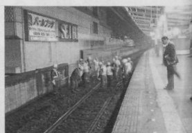
深夜の保線工事 （JR船橋駅上り線路）
