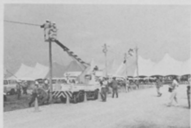
高所作業車を使い応急復旧作業を行う東京電力。
