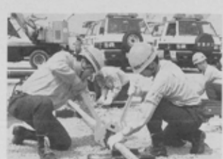
京葉ガスによるガス管の復旧作業。
