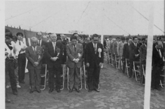
工事の安全を祈る大橋和夫市長と工事関係者。
