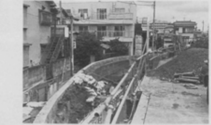
川の流れをスムーズにするため、カーブもゆるやかに直されている。
