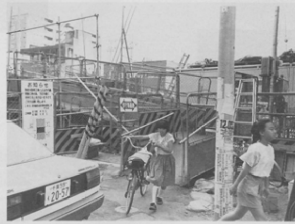
着々と工事が進められる万代橋。工事期間中ご迷惑をおかけします。
