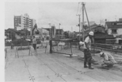
昭和65年の完成に向け、拡幅工事が進む海老川。(栄橋付近)
