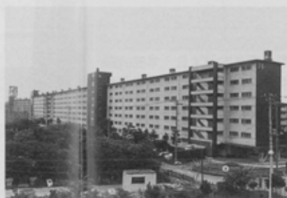
長さ400メートルの若松団地の2-6-1号棟は、団地の建物としては市内で一番長い。
