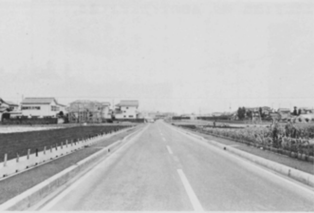
8月1日に開通したばかりの(市道2030号線)一段と東西移動が楽になった。(上山町2)
