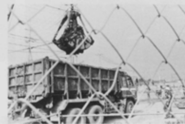
昭和68年の開通を目指し、工事が進む東葉高速鉄道(本町7丁目付近)
