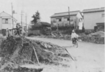
JR船橋駅北口交差点を左折し300Mほど進んだところで都市計画道路3・4・20号線の建設が進められている。やがて行田へ続き、将来は市川市まで伸びる予定だ。
