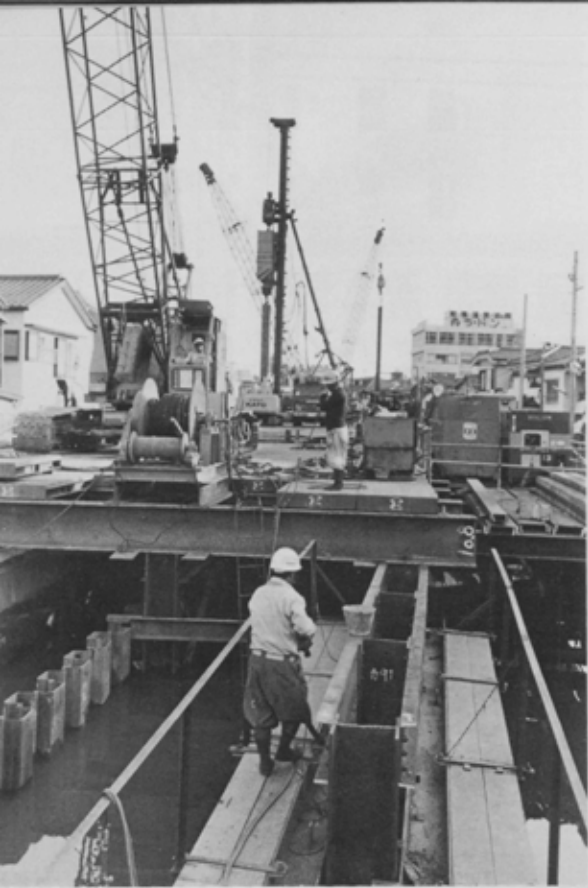
都市型水害から市民生活を守るため 着々と拡幅工事が進む海老川
