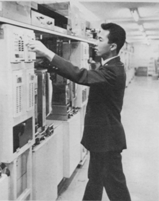
自動券売機のウラ側。25台の機械が午前4時から翌日の深夜1時すぎまで休みなく動いている。機械が発する熱で室内はかなり熱い。
