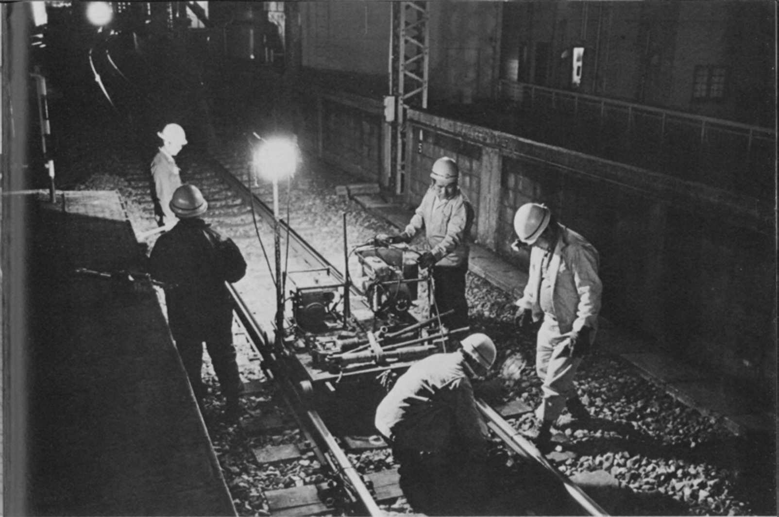
午前1時。すでに最終電車が行ってしまった上りの車線では、作業員によって入念にレールのチェックが行われる。安全運転を支える重要な作業だ。
