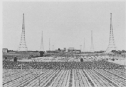
昭和16年「ニイタカヤマノボレ」の暗号が発信された行田の無線塔。昭和46年に解体され跡地には行田団地が建設された。
