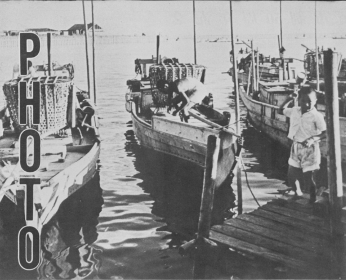
船橋海岸(昭和27年9月)国道14号線船橋橋際より現在のらぼーと方面を望む(寺田俊一氏撮影)
