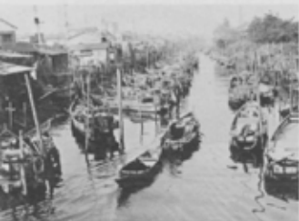
市役所付近の山谷湾には最近までペカ舟が並んでいたが、現在では埋立てられ、新工法によって固められている。
