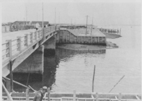
昭和30年2月現在の国道14号線船橋橋のあたりから船橋港方面を望む。左側奥ではヘルスセンターの建設工事が進められている。
