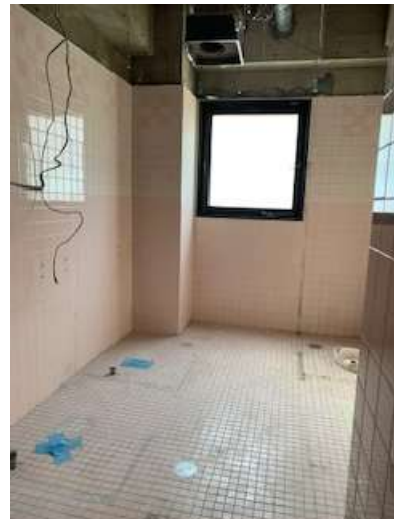
6月30日現在 便器等撤去後
