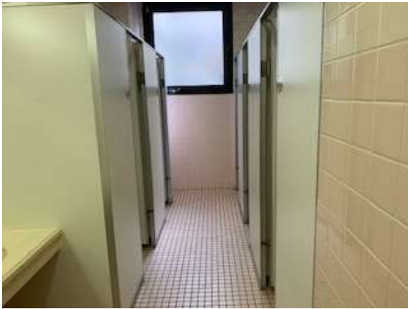
女子トイレ改修前
