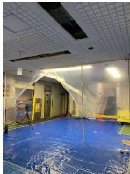
6 月 3 0 日現在 電気撤去し養生
