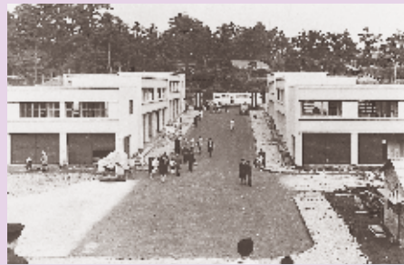
開業したばかりの西船橋駅北口 昭和33年
