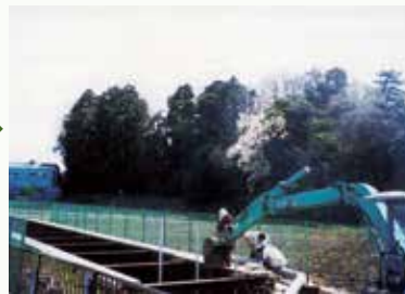
平成15年(2003) 中野木川の護岸工事が進む
