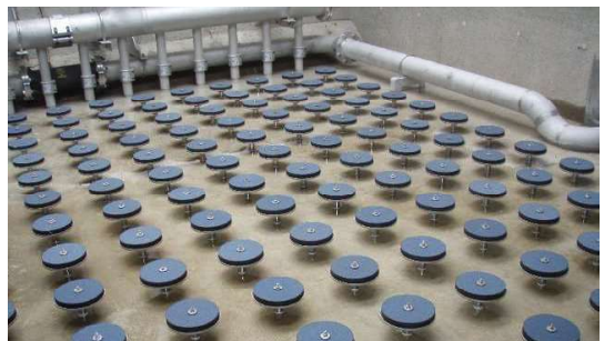
散気装置 (参考 平成14年設置当時)
