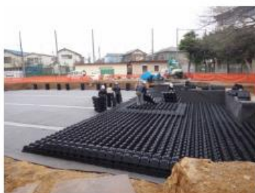
貯留浸透槽組立中
