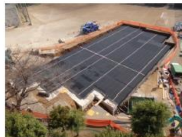
貯留浸透槽組立完了
