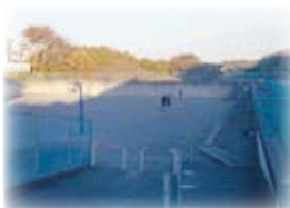
▲ (みのり台調整池)
