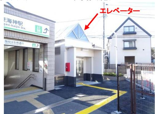
・視覚障害者の転落を防止するための設備(内方線付き点状ブロック)の整備
