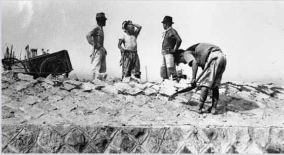
■都疎浜海岸最初の護岸工事 昭和23年
