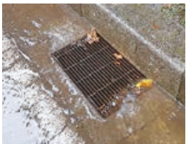
▲集水ますに雨水が流れ込み排水される
