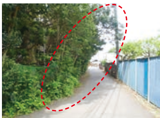
▲道にはみ出した樹木
