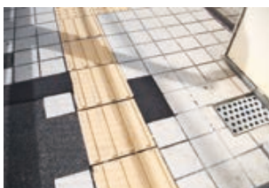
▲補修対応完了！
