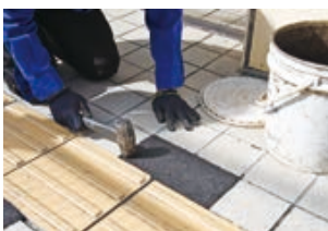
▲歩道橋のタイルが剥がれた部分を補修の様子
