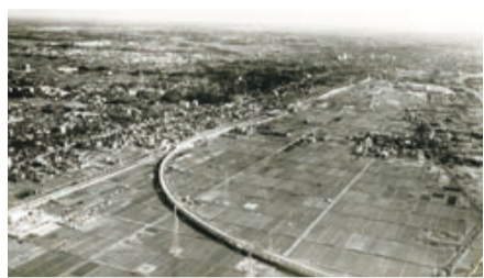
▲地下鉄東西線の建設が進む国鉄西船橋駅(昭和43年)
