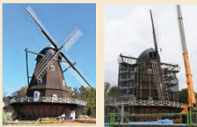
▲改修前の風車 ▲改修中の風車
