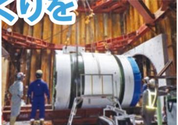
▲山手1丁目地区に設置する直径2.6メートルの雨水管
