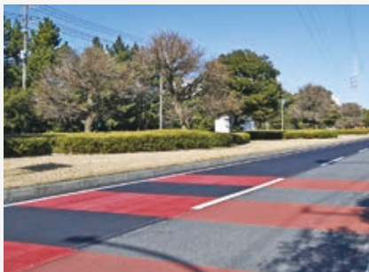
▲この舗装(施工面積約1200平方メートル)で、最大約1万7000本分のペットボトル(500ミリリットル)を再利用しています
