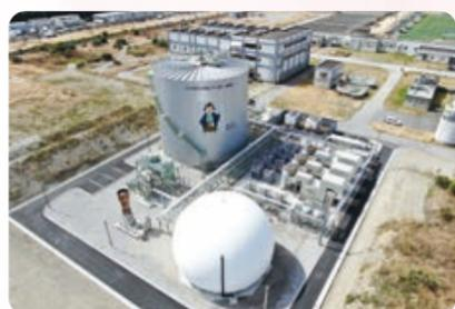
◀消化ガス(メタンガス)を燃料としたバイオマス発電を開始した高瀬下水処理場
