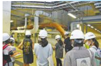
▲処理場の管は中身が一目で分かるように色分けされています
