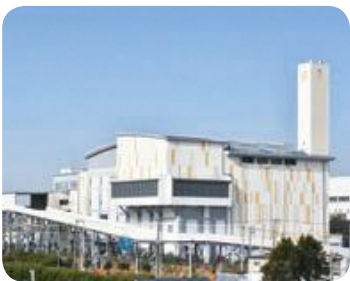
▲4月から稼働する「ふなばしさざぶら」。処理能力は1日最大339トンです
