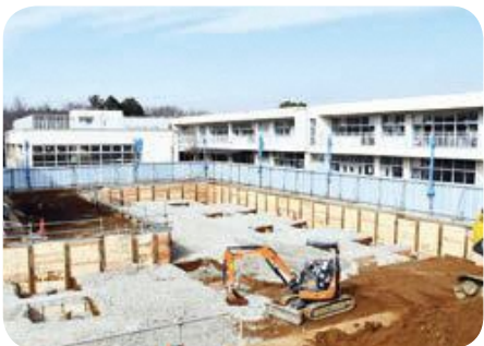
▲増築に向けて着々と工事を行う金堀校舎
