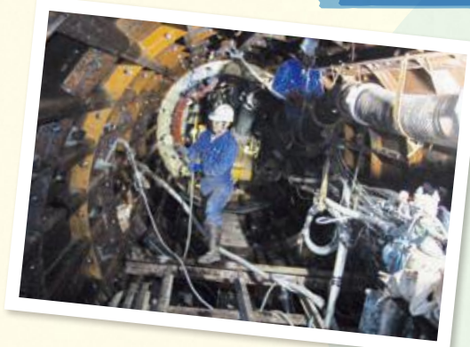
▲シールド工法による下水道管の整備が進められました(平成17年)
