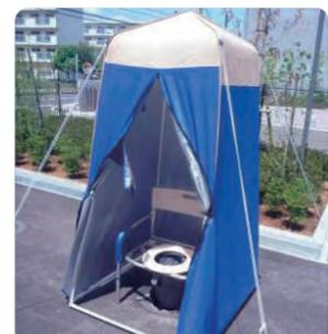
▲設置が容易で、し尿を直接下水道管に流せる「マンホールトイレ」
