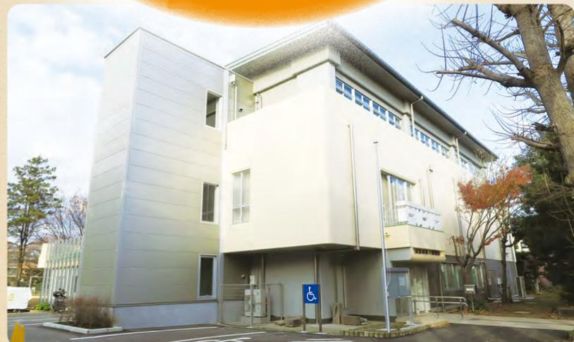
▲昭和47年に建設されたため老朽化が進み、平成27年から耐震補強やエレベーター設置工事を実施。展示内容が充実し、安全性・利便性も向上しました
