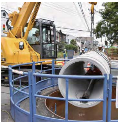
▲飯山満駅周辺で行われている工事
