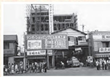
▲かつて国鉄津田沼駅北口にあったサンポートショッピングビルの新築工事(昭和42年)
