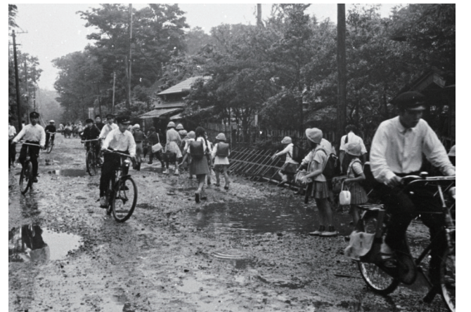
▲当時は舗装されている道路が少なく、雨が降るとぬかるんで歩行が困難になりました(写真は昭和37年の木下街道)
