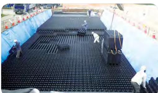
▲雨水を効率的に貯留・浸透させる雨水貯留浸透施設 (27年度設置の高根台中)
