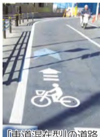
「車道混在型」の道路 とされる方法(上写真)を整備していきます。
