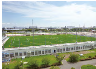
▲高瀬下水処理場の屋上を利用した人工芝の運動広場
