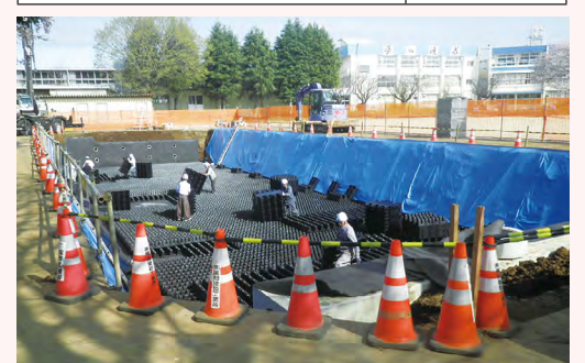
▲軽量で扱いやすく、雨水を効率的に貯留・浸透させることができるプラスチック製の施設(27年度設置の高根台中)
