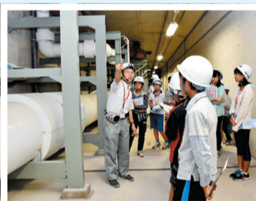
▲地下にはたくさんの巨大な配管が張り巡らされていました
