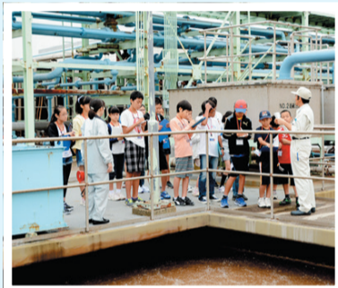
▲微生物の力で食品工場の排水をきれいにする「ばっ気槽」を見学
