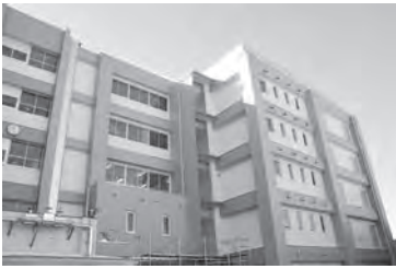
▲現在行われている外構工事等も3月には終了します
