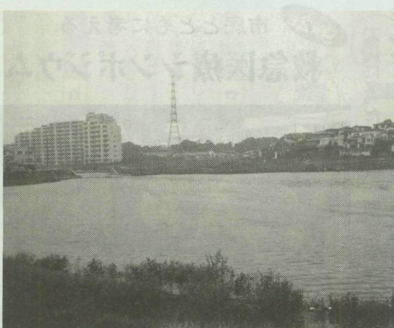
長津川に設けられた調節池。上流地域からの雨水を受けとめて、水害の防止に大きな役割を果たしました
