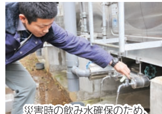
災害時の飲み水確保のため、受水槽に給水栓を設置
