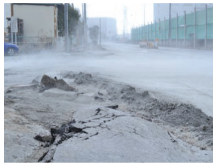
液状化により道路に亀裂が入ったり、建物や電柱が傾いたりしました(潮見町)
