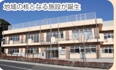
地域の核となる施設が誕生
