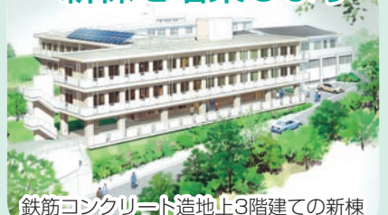
鉄筋コンクリート造地上3階建ての新棟
