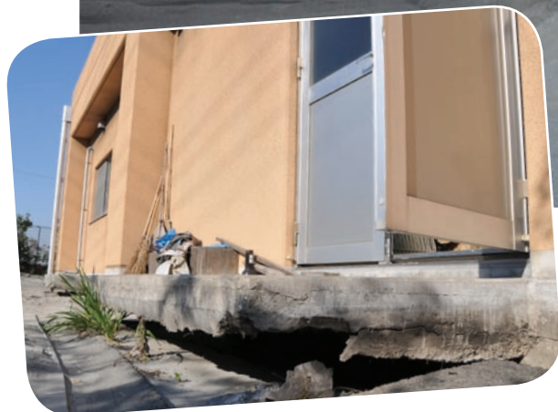
▲地盤沈下により建物の周囲に亀裂が入りました(動物愛護指導センター)
