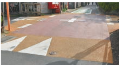
ハンプ 路面に凸部を設け、車両の走行速度の減速を促します
