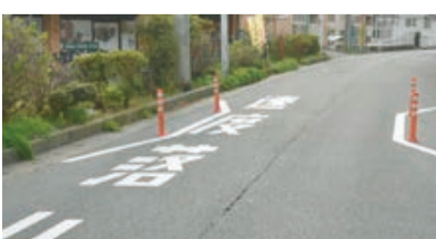
狭さく 車両の通行部分の幅員を狭め、走行速度を抑制させます
