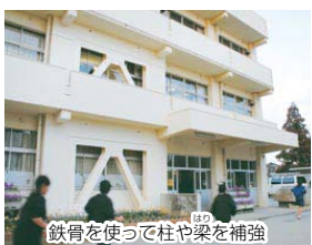
鉄骨を使って柱や梁を補強
