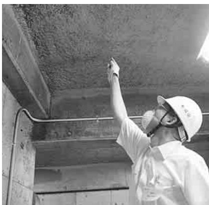
▲市役所本庁舎屋上の機械室で行われた使用状況調査
