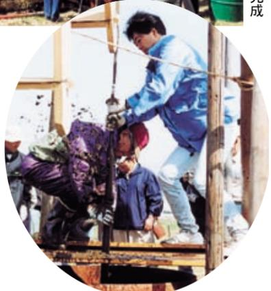
掘削当初、砂地を掘りやすくするために流し込んだ水と粘土が吹き上げる
